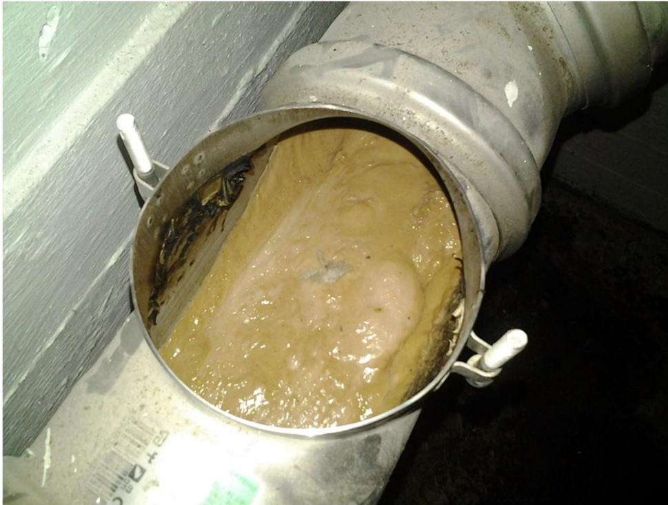
Kiinteistön putket rasvassa
